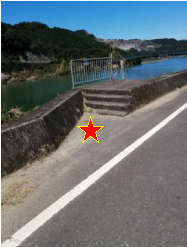
※停車標識柱を設置いたします。
