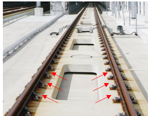
▲ レールを締結しているボルト
