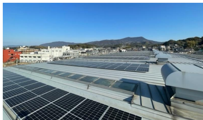
佐世保車両センター 屋根上
