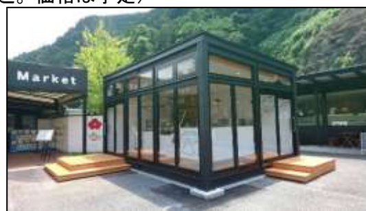
Gelateria LAB3680 OKUHITA 外観（建設中）
