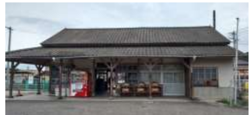
唐津線 山本駅舎
