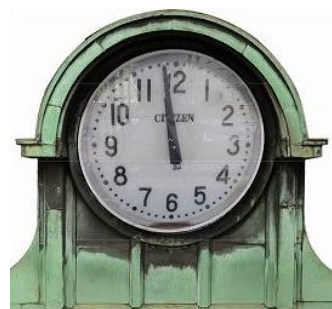
▲保存修理工事前時計：3代目時計
