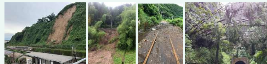
切取斜面の崩壊
