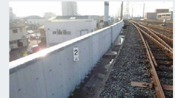
「スムーズボード工法」を用いた高架橋
