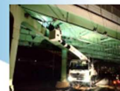
跨線道路橋の包括的維持管理
