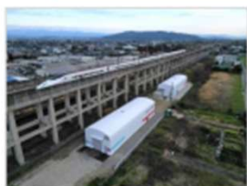
系統用蓄電事業 (でんきの駅)
