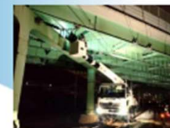
跨線道路橋の包括的維持管理
