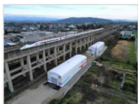
系統用蓄電事業 (でんきの駅)
