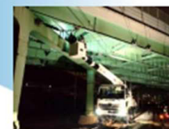
跨線道路橋の包括的維持管理
