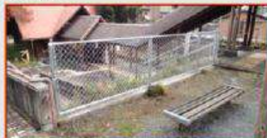
転落防止用のフェンスを設置
