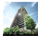
MJR堺筋本町タワー
