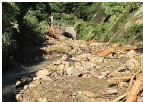
■日豊本線 津久見～日代間 土砂流入
