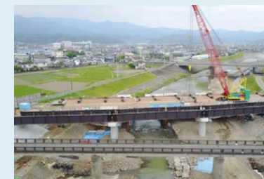
久大本線の復旧作業
