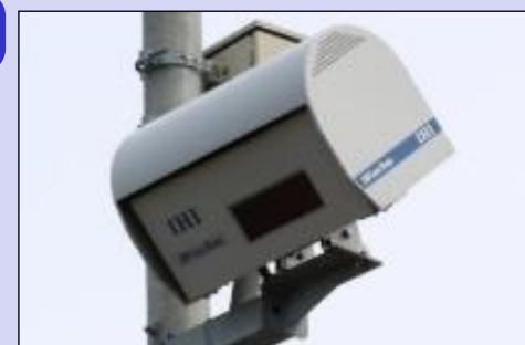
〔踏切障害物検知装置(3D式)〕
