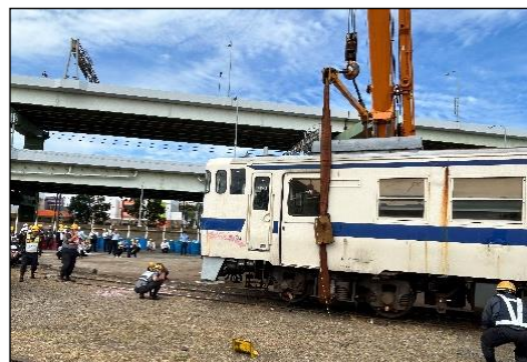
〔クレーンによる列車の載線〕
