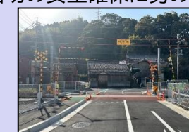
〔拡幅後(カラー舗装)〕
