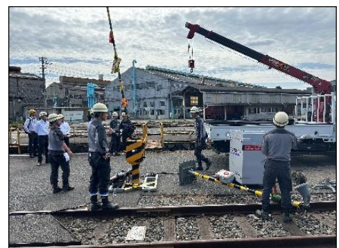
〔踏切復旧作業〕
