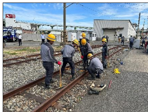
〔軌道復旧作業〕
