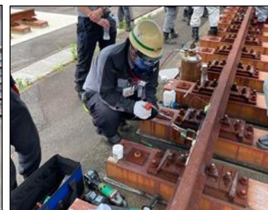
〔軌道回路復旧訓練〕
