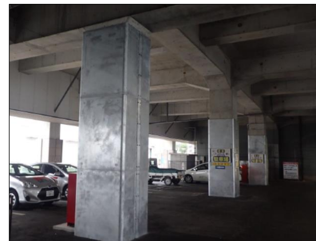
〔鋼板巻立補強工法(行橋駅)〕
