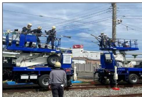
〔架線復旧作業〕
