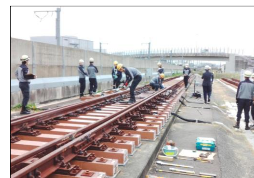
〔工務関係技能競技会(分岐器)〕
