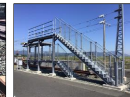
〔車両屋上機器点検台〕
