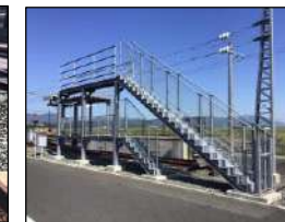
[車両屋上機器点検台]
