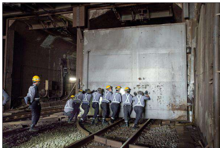
〔トンネル内防水扉の閉扉〕
