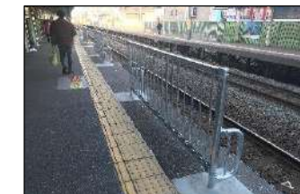
〔ホーム固定柵(笹原駅)〕
