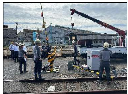
〔踏切復旧作業〕
