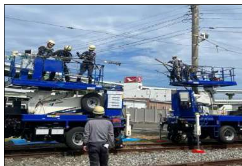
〔架線復旧作業〕
