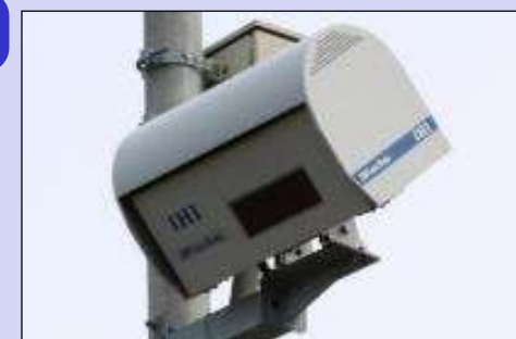
〔踏切障害物検知装置(3D式)〕
