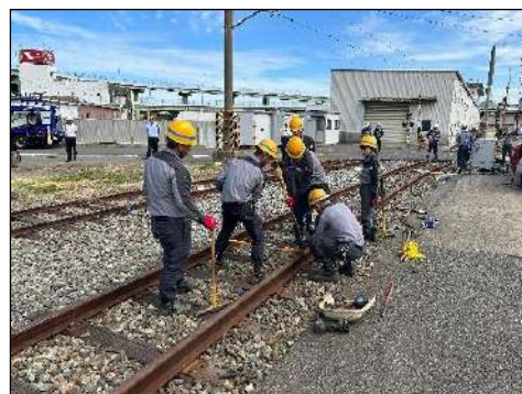
〔軌道復旧作業〕
