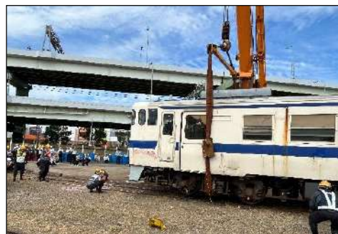
〔クレーンによる列車の載線〕
