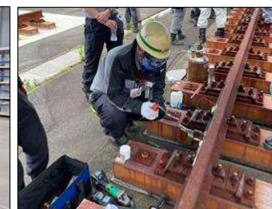
〔軌道回路復旧訓練〕
