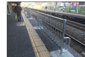
〔ホーム固定柵(博多駅)〕
