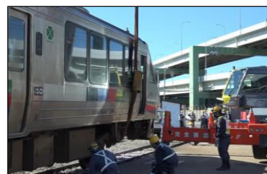
〔クレーンによる列車の載線〕
