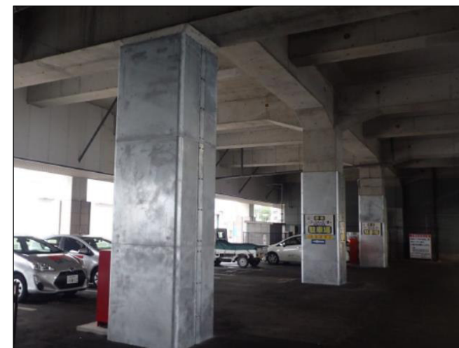
〔鋼板巻立補強工法(行橋駅)〕
