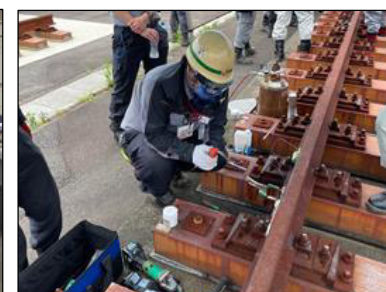
〔軌道回路復旧訓練〕
