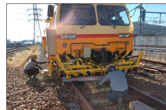
〔保守用車脱線復旧競技会〕
