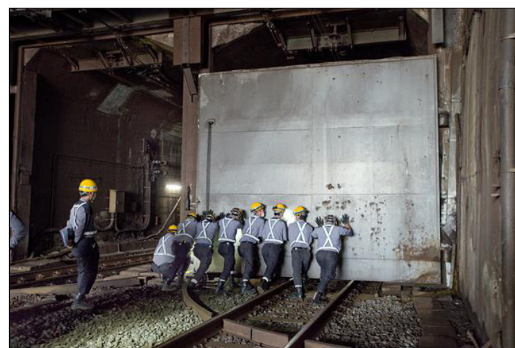
〔トンネル内防水扉の閉扉〕
