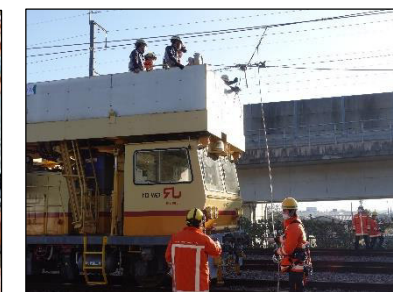
〔電車線路復旧訓練〕
