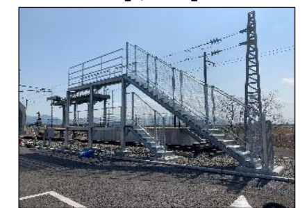
〔車両屋上機器点検台〕
