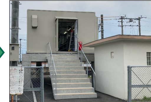
〔信号機器室嵩上げ(浸水対策)〕
