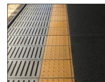
〔内方線付き点状ブロック〕
