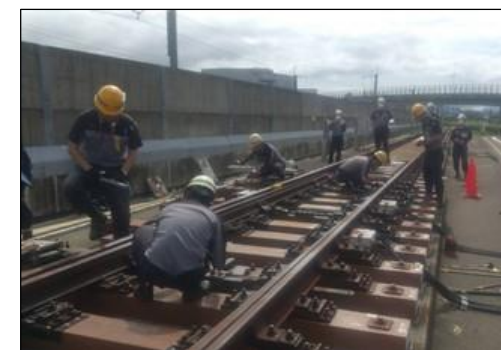
〔工務関係技能競技会(分岐器)〕
