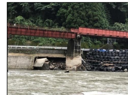
〔護岸損傷〕
