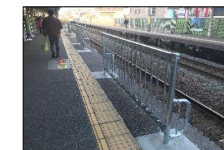
〔ホーム固定柵(笹原駅)〕
