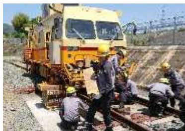
〔保守用車脱線復旧競技会〕
