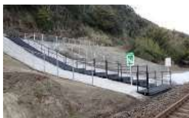
〔津波避難階段(2019年度新設)〕
