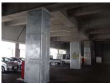
〔鋼板巻立補強工法(行橋駅)〕
