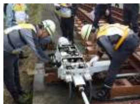
〔工務関係技能競技会(分岐器)〕
