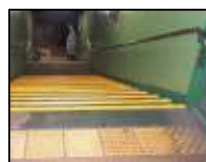
〔設備改善事例〕
