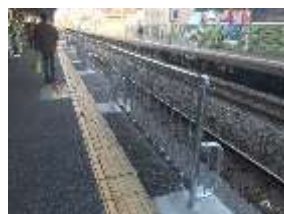
〔ホーム固定柵（笹原駅）〕
