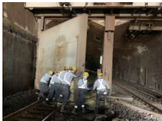
〔トンネル内防水扉の閉扉〕
