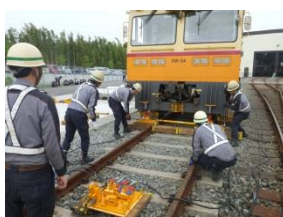
〔保守用車脱線復旧競技会〕
