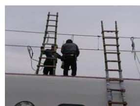
〔車両上での電車線復旧訓練〕
