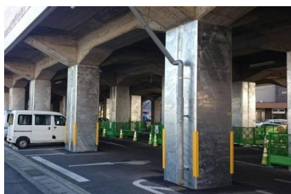
〔鋼板巻立補強工法(別府駅)〕
