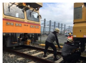
〔軌陸車異常時取扱訓練〕
