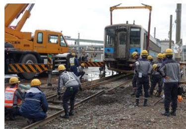
〔クレーンによる列車の載線(本社直轄)〕
