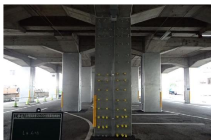
〔一面耐震補強工法(行橋駅)〕
