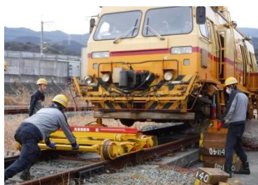
〔保守用車脱線復旧訓練〕
