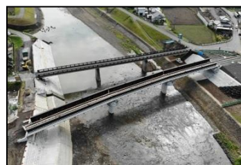
〔橋りょうの復旧〕
