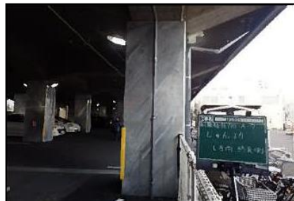
〔鋼板巻立補強工法(別府駅)〕
