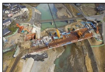
〔橋りょうの復旧工事〕
