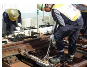
〔工務関係技能競技会(分岐器)〕
