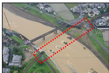
〔橋りょうの流失〕
