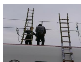
〔車両上での電車線復旧訓練〕
