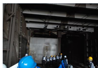
[トンネル内防水扉の閉扉]
