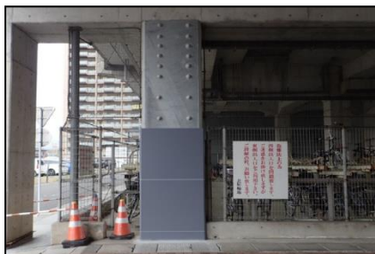
〔一面耐震補強工法(行橋駅)〕
