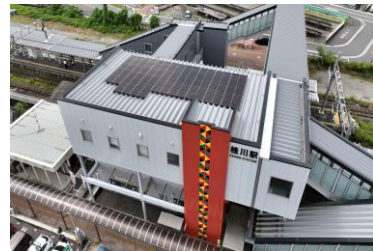
桂川駅 駅舎屋根上
