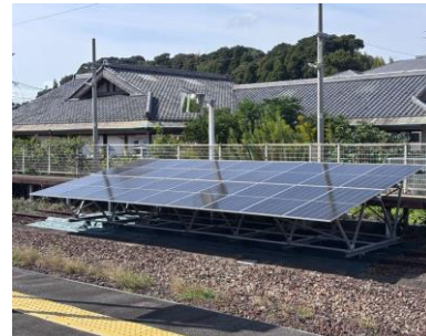
佐土原駅レールへの設置状況
