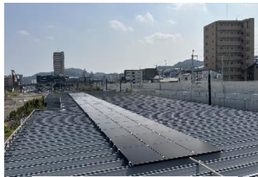
長崎工務所 事務所屋根上
