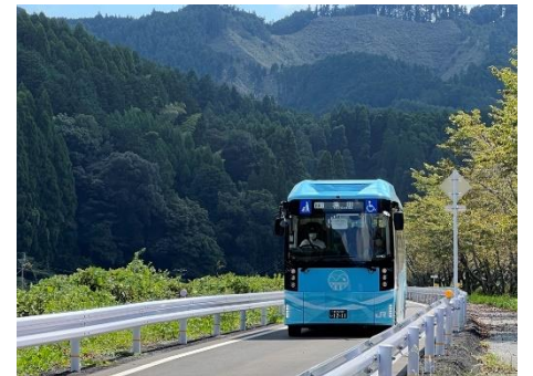
グリーン舗装で整備されたBRT専用道
