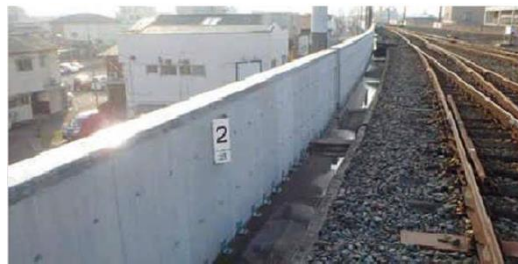
スームスボード工法を用いた高架橋
