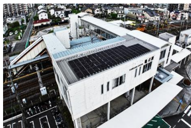
亀川駅 駅舎屋根上
