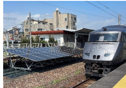
レールPV横を特急列車が走行する様子
