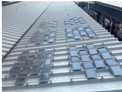
モックアップ (2ホーム熊本方面に設置)
