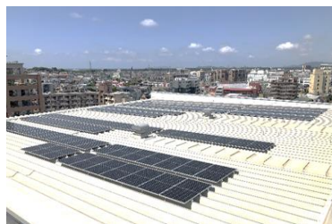
福工大前駅 駅舎屋根上
