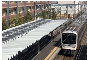
新宮中央駅 ホーム屋根上
