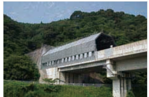
トンネル緩衝工
