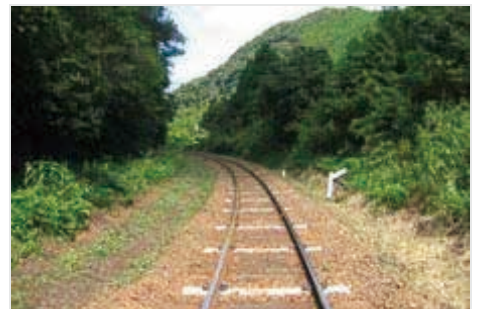
TPCまくらぎの敷設
