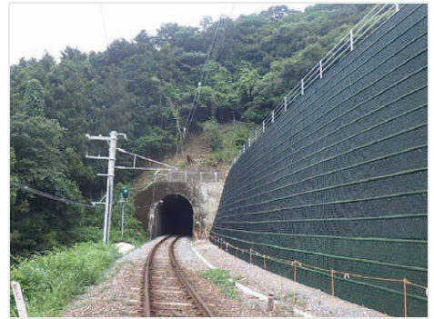
ジオロックウォール工法を用いた擁壁
