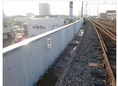
スムースボード工法を用いた高架橋
