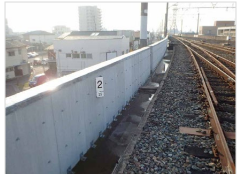
スムーズボード工法を用いた高架橋
