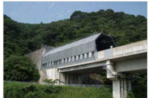
トンネル緩衝工
