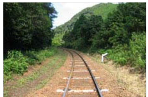
TPCまぐらぎの敷設
