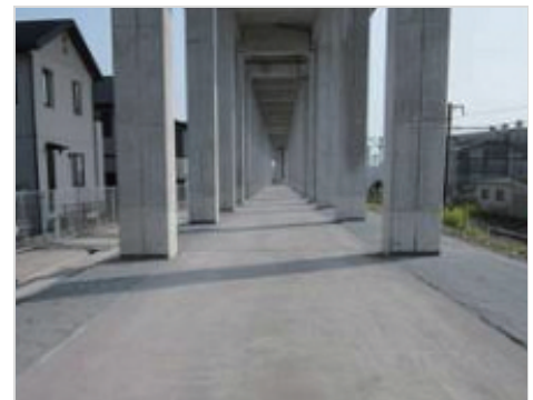
鉄鋼スラグで防草対策を行った新幹線高架下
