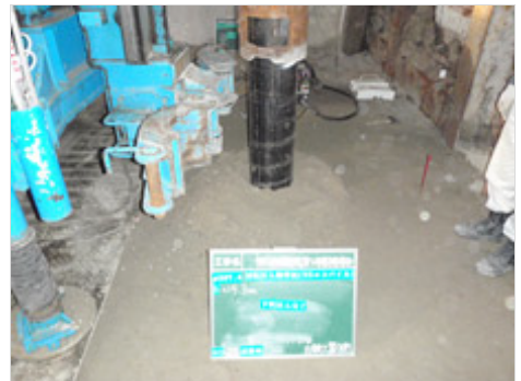
高架下建物新築工事（杭打設状況）
