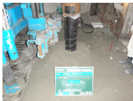
高架下建物新築工事（杭打設状況）
