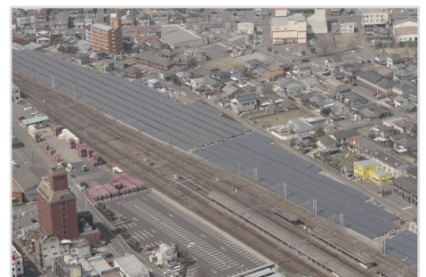
都城太陽光発電所
