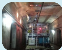
トンネル × 専用車調査
