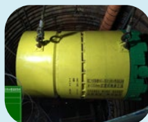
水道 × 水路新設工事
