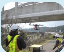
橋 × ドローン調査
