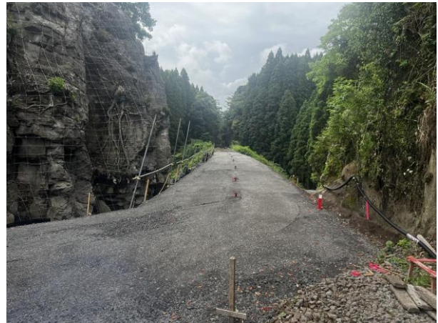
復旧工事の状況（2026年5月25日時点）
