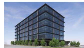
(仮称) JR肥後大津ビル (2027年春竣工予定)
