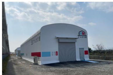
図2：正面横からの外観
