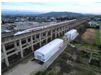
図1：上空からの外観
