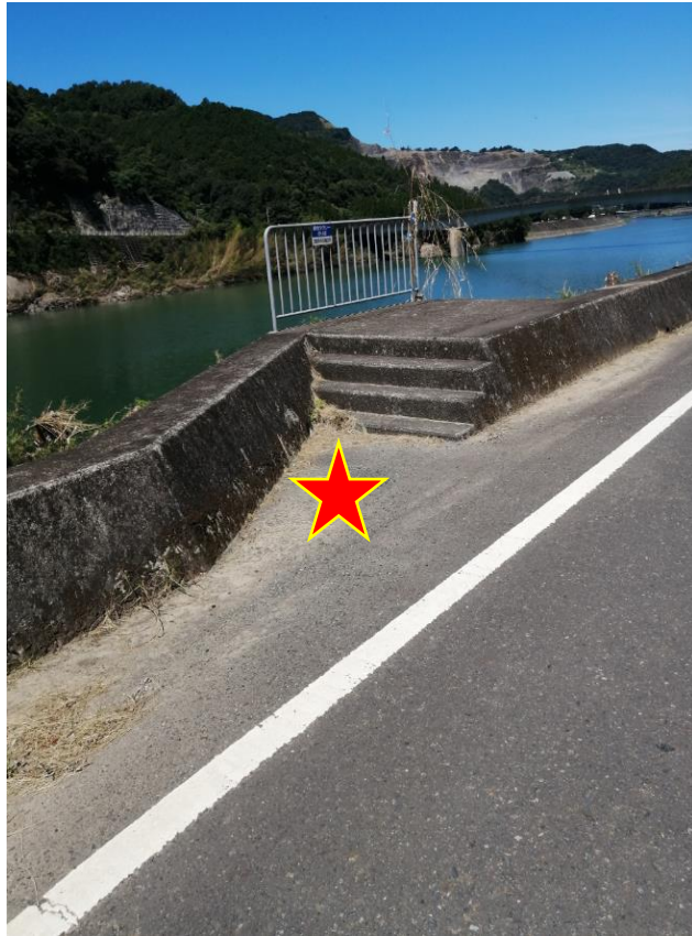
※停車標識柱を設置いたします。
