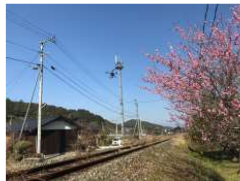
鉄道施設点検状況
