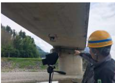
鉄道施設点検状況
