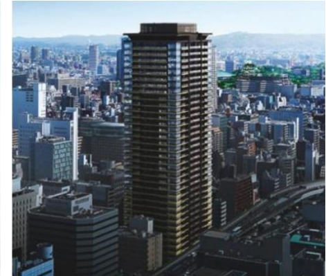
MJR/RJR Sakaisuji Hommachi Tower
