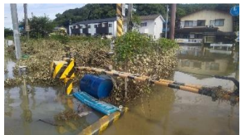
冠水による踏切設備の被災
