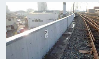
「スムーズボード工法」を用いた高架橋
