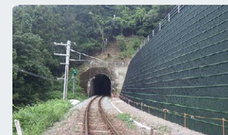
「ジオロックウォール工法」を用いた擁壁
