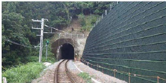
ジオロックウォール工法を用いた擁壁
