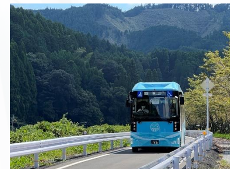
グリーン舗装で整備されたBRT専用道
