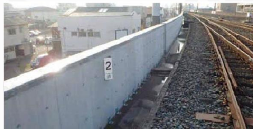
スムーズボード工法を用いた高架橋
