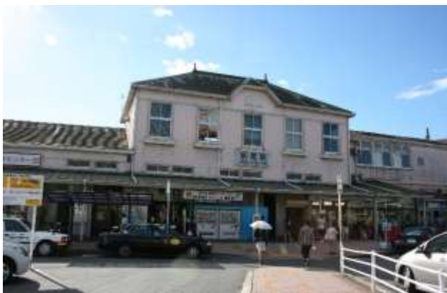
△旧折尾駅駅舎
