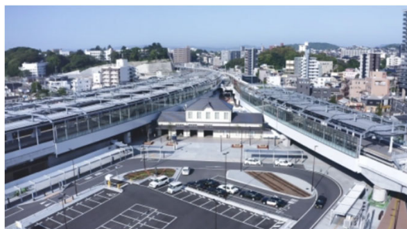
連続立体交差事業 | 2022年高架化完了
