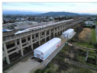
系統用蓄電事業 (でんきの駅)
