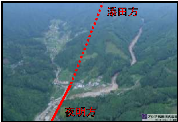
筑前岩屋駅構内 55k070付近
