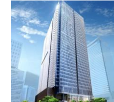
虎ノ門アルセアタワー (2025.2竣工)
