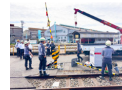
踏切復旧作業
