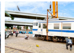
クレーンによる列車の載線
