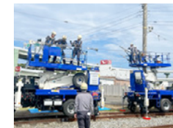
架線復旧作業
