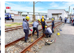
軌道復旧作業
