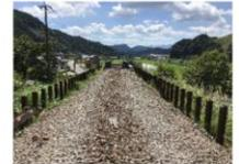
線路のレールは切断して専用道の土留杭として地盤へ打ち込み、バラストは砂利とまぜて舗装の基盤として再利用
