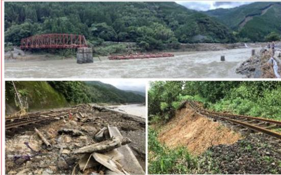
\*1]・球磨川を渡河する橋りょう（球磨川第1橋りょう、第二球磨川橋りょう）については、2021年12月に変更された「河川整備基本方針」に基づく計画高水位を参考に、橋りょうの復旧高さを設定し概算復旧費を算出
