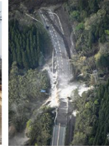
<立野駅～赤水駅間 土砂流入による線路流出>
